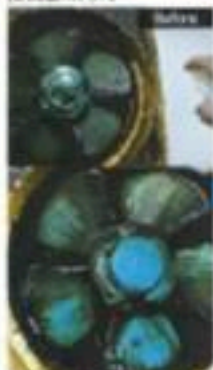
換気扇の汚れ
